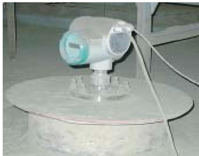
▲ SITRANS LR400用于含有严重粉尘条件的水泥工艺生产,提供可靠读数
